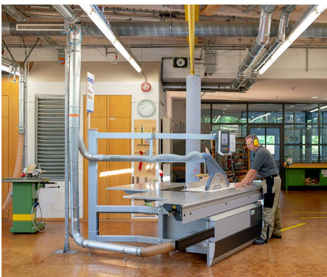
Abb. 11 Formatkreissäge mit abgesaugter Schutzhaube und Absaugung unterhalb des Tisches
